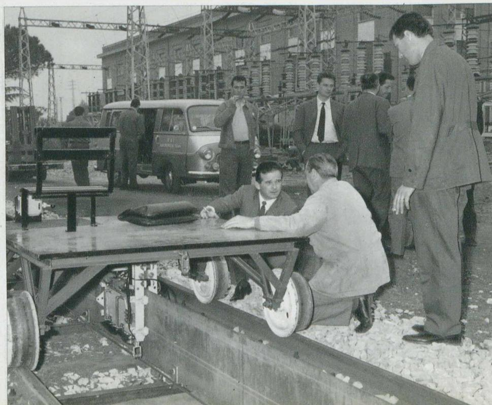
Esperimenti per la realizzazione di un motore lineare ad induzione
