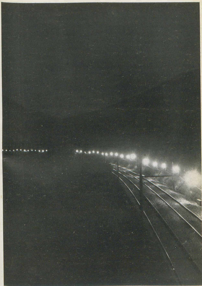
Illuminazione per lavori notturni d'emergenza.
