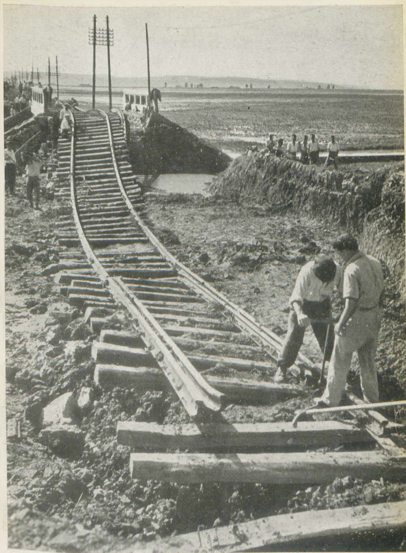
Riparazione dei danni causati in Sicilia dalle alluvioni dell'ottobre 1951.
