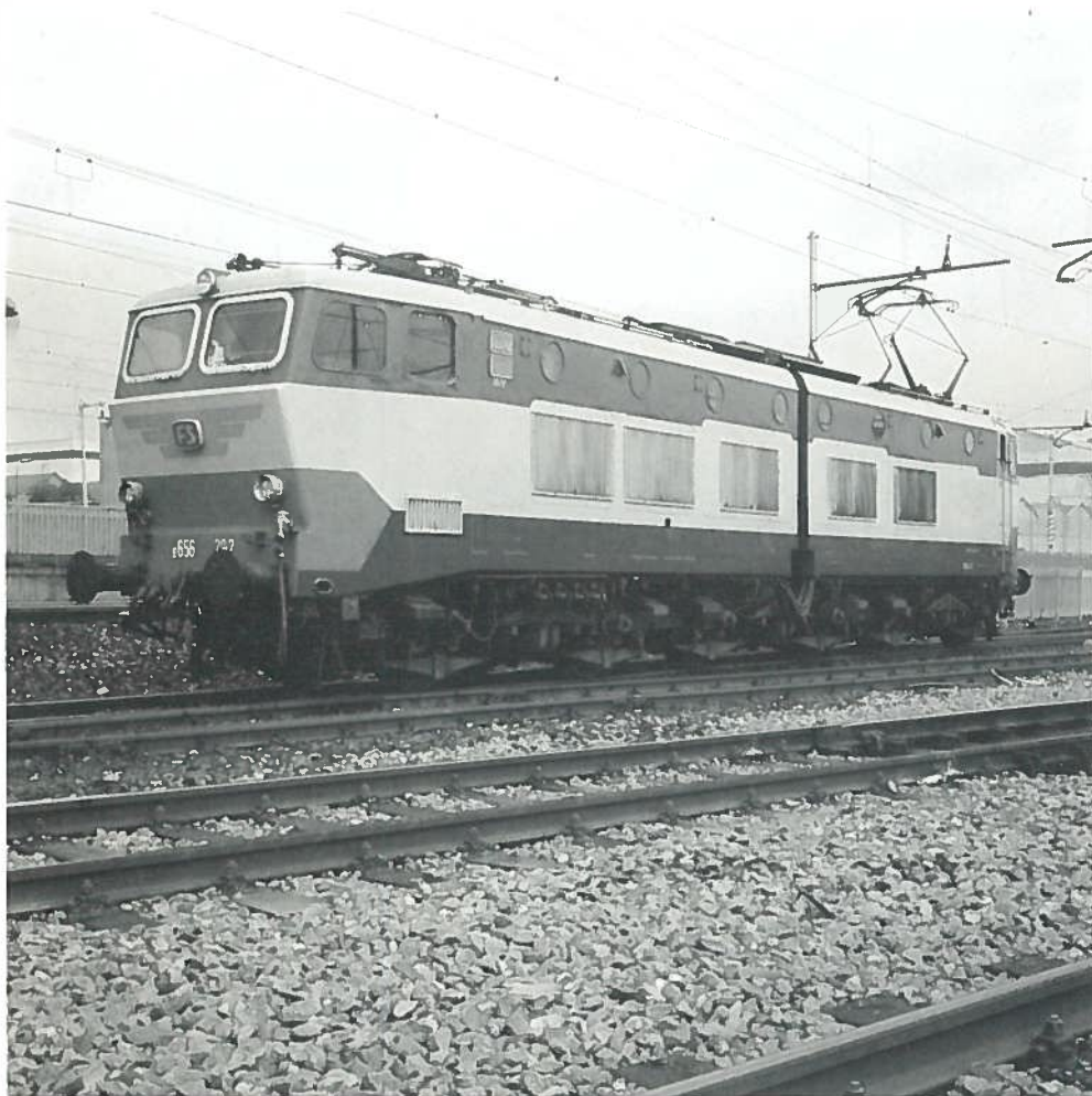
Locomotiva elettrica E.656.292, Tibb 1978: 12 x 400 kW, 120 t, 150 km/h; 403 unità in servizio e in costruzione.
