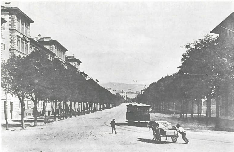
L'attuale sede della Direzione Generale del Servizio Materiale e Trazione, nel viale Lavagnini, come si presentava all'inizio del secolo e com'è oggi.
