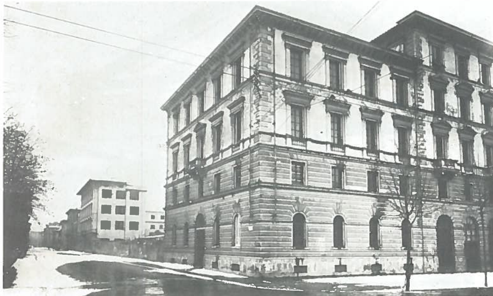
Il lato prospiciente via Lorenzo il Magnifico, prima e dopo l'ampliamento del 1950.
